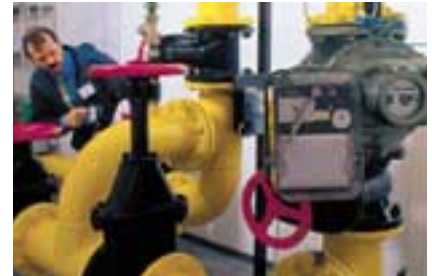
Überprüfung einer Gasübergabestation
