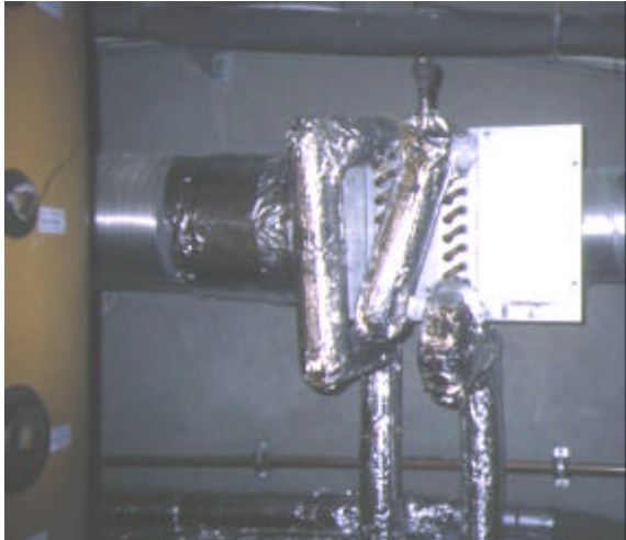
Abbildung 9: Nachheizregister in der Zuluftleitung im Technikgeschoß (links ungedämmt, rechts wärmegeklämmt)
