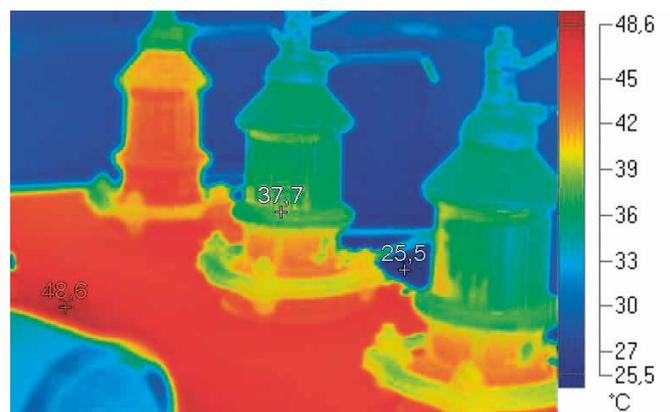
Durch fehlerhafte elektrische Anlagen entsteht ein potenzielles Brandrisiko. Thermographie ermöglicht es uns, diese Gefahrenpotenziale zu erkennen.
